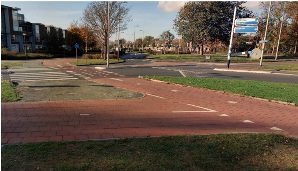
Oversteek Wijk aan Duinerweg (zuidkant Plesmanweg)
